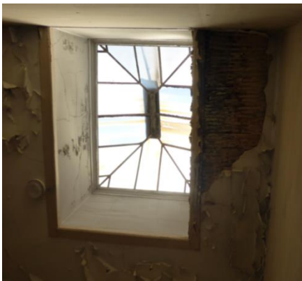
Estafe com zonas em falta por destacamento e queda devido a presença de águas através da clarabóia
