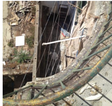
Degradação da estrutura das varandas e oxidação das guardas metálicas
