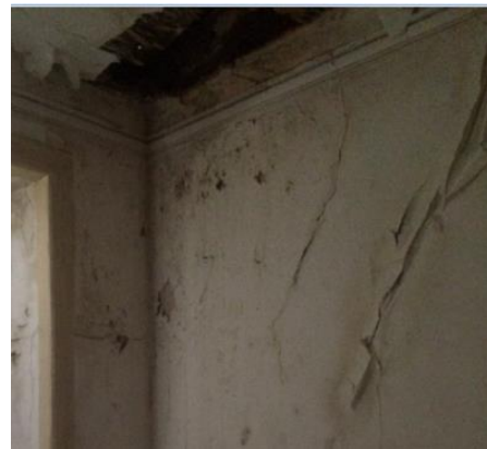
Fissuras e empolamentos nos revestimentos e nas pinturas
