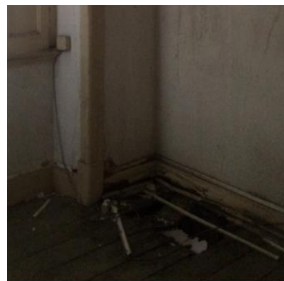
Envelhecimento, degradação das estruturas de madeira devido a acção de fungos ou insectos xilófagos
