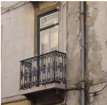
Presença de sujidade nas cantarias, degradação de revestimentos e pintura
