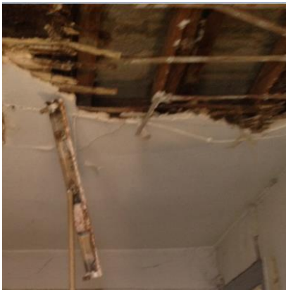
Apodrecimento e rotura das estruturas dos pavimentos em madeira, degradação dos tectos
